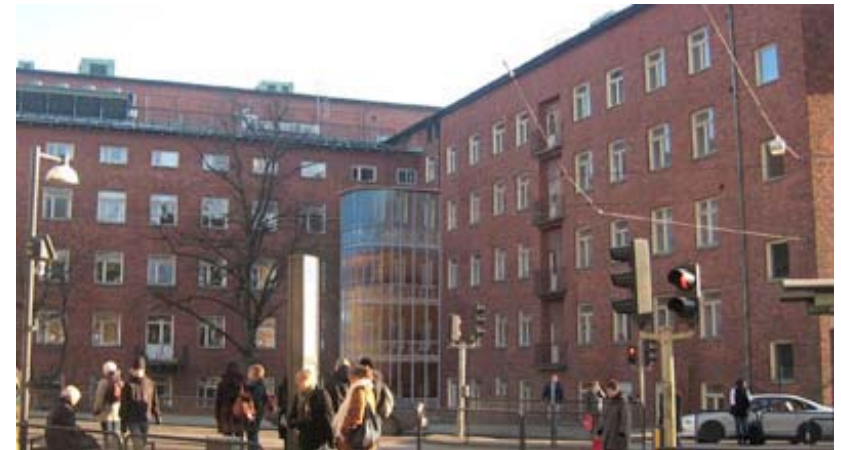
Bilden visar de nya förbindelsegångar som kommer att byggas i hörnet mellan de båda flyglarna.
